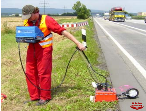
Leitungserkundung, elektronische Suchschachtung
